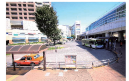
【整備事例】池袋線石神井公園駅 北口駅前広場
